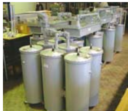
Устройство сложения 4-х канальное УКВ ЧМ
